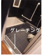
グレーチングを設けることでフラットな設計とした浴室出入口
